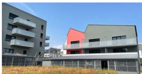
LANESTER (56) , résidence Les Hunes du Scorff, 12 logements locatifs et 49 logements en accession à la propriété
