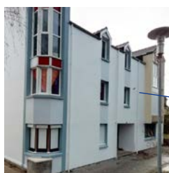
BREST , résidence La Cavale Blanche, 46 logements
