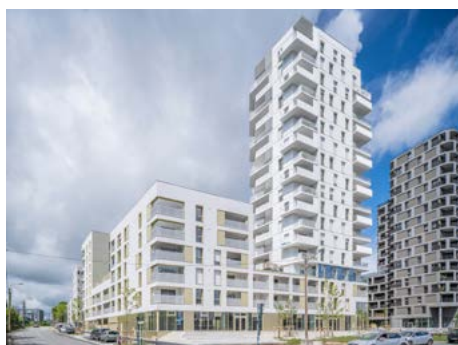
RENNES (35) , résidence Dremmwel, 46 logements locatifs et 80 logements en accession à la propriété
