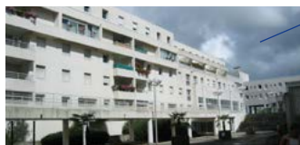
LORIENT , résidence Les Terrasses de l'Atlantique, 35 logements
