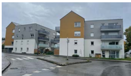
MONTFORT-SUR-MEU (35) , résidence Henri Saintin, 36 logements locatifs
