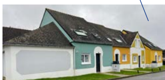
LANESTER , résidence Velleda, 32 logements
