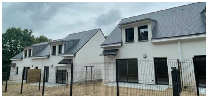
LANDÉVANT (56) , résidence Lann Vraz, 8 maisons locatives
