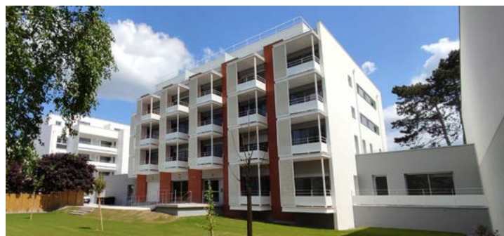
RENNES (35), résidence Les Amarantes, 15 logements locatifs et une résidence sociale de 34 logements
