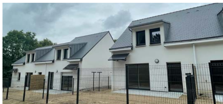
LANDÉVANT (56), résidence Lann Vraz, 8 maisons locatives
