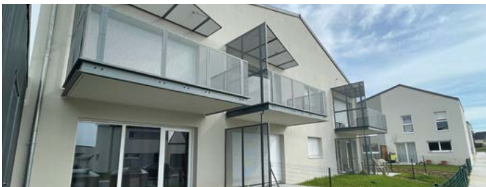
ARGENTRÉ-DU-PLESSIS (35), Résidence Espace Van Gogh, 24 logements locatifs
