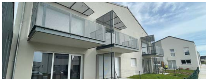
ARGENTRÉ-DU-PLESSIS (35), Résidence Espace Van Gogh, 24 logements locatifs
