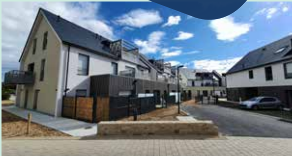
Résidence Lokentaz, 24 logements locatifs.
