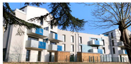
MELESSE (35) , résidence Les Jardins du Feuill, 33 logements locatifs
