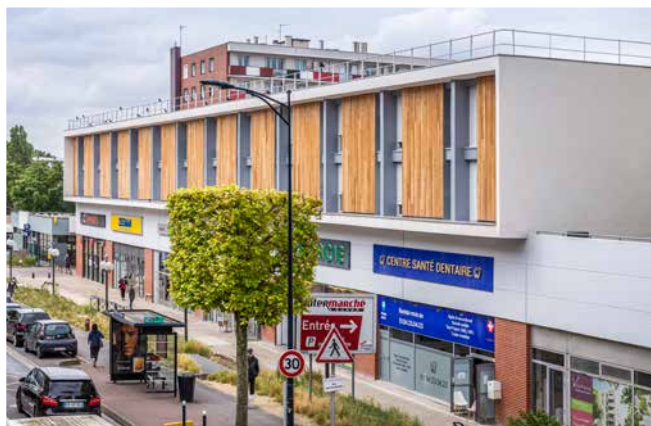
CHAMPIGNY-SUR-MARNE RÉSIDENCE SIMONE LAMBRE Architecte : Groupe A 94 logements pour étudiants
