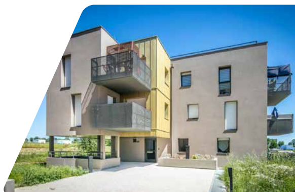
Vern-sur-Seiche (35), résidence L'Oppidum, 37 logements dont 18 réservés via Action Logement Services.
