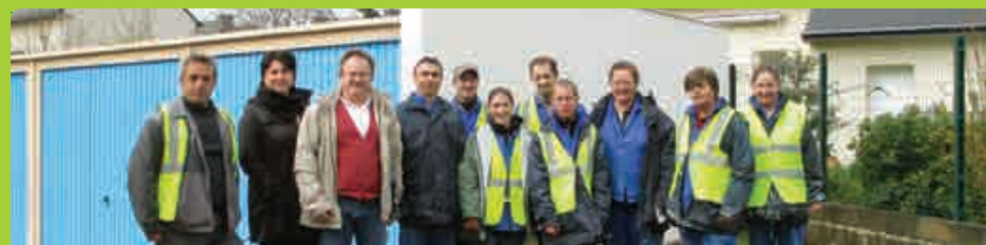
A Lanester, une dizaine de personnes participent aux travaux d'amélioration de La Châtaigneraie.
