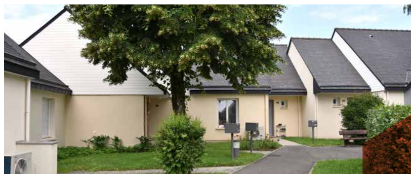
Treffendel (35), travaux d'amélioration de la résidence Beauséjour : 12 pavillons qui passent de l'étiquette énergétique E à B.
