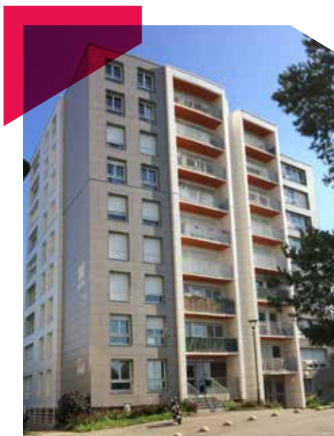
À Rennes (35), réhabilitation de L'Ormoie (42 logements locatifs).
