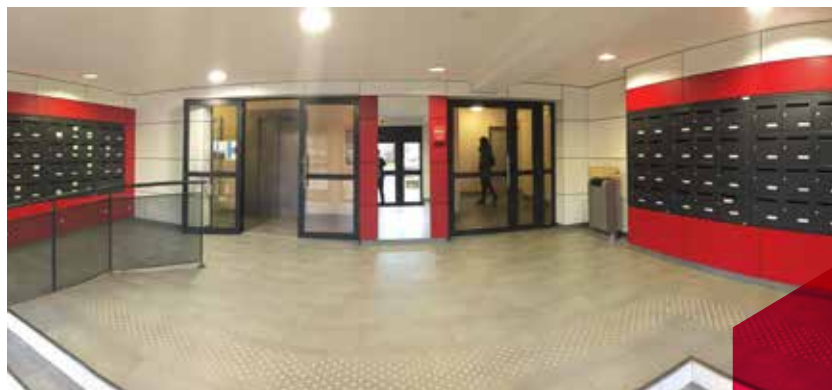
Rennes (35), rénovation d'un hall d'immeuble dans le quartier du Blossne.
