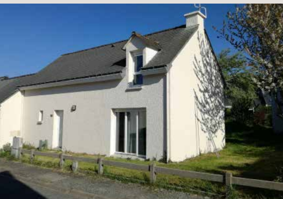
Guidel (56), travaux d'amélioration de la résidence Kerouat Elle.
